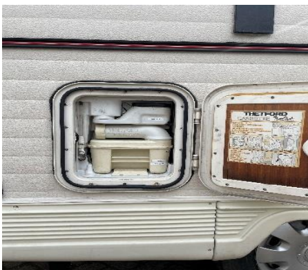
(afb. 11) WC ruimte
